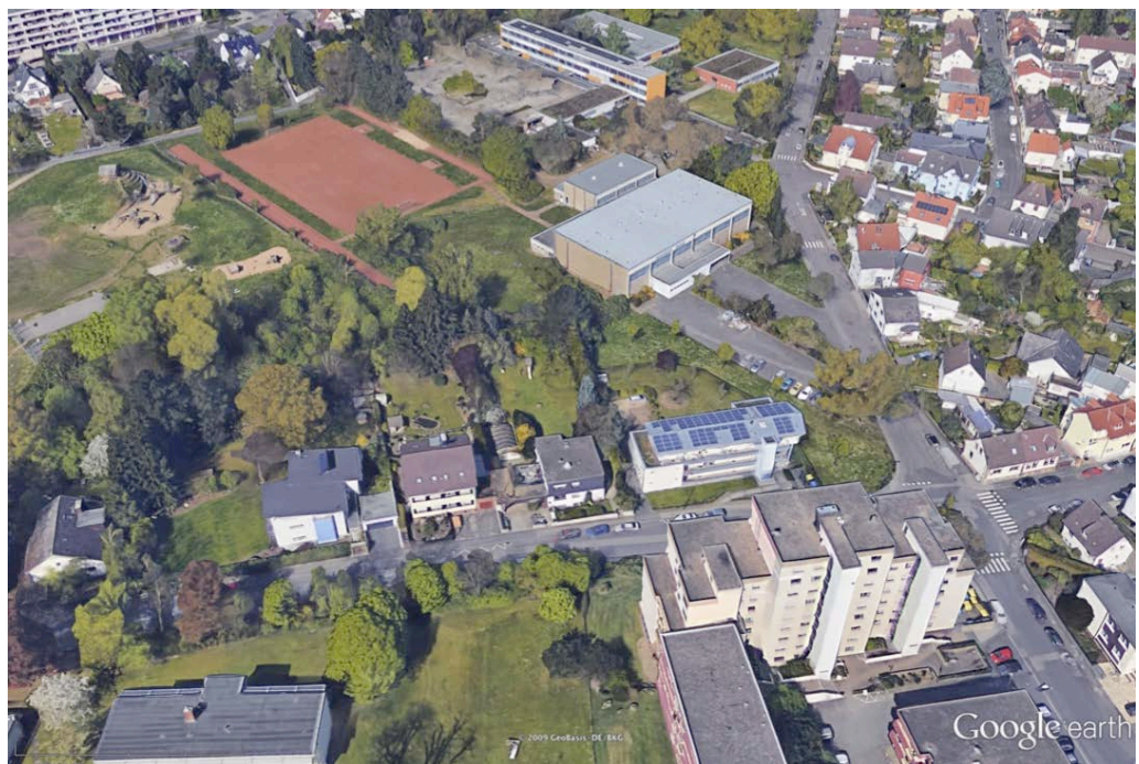
Plangebiet und Umfeld (Google Earth)
