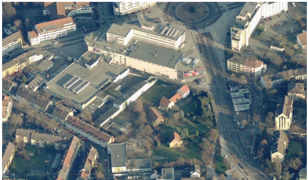
Plangebiet + Umfeld von Westen aus Bing Maps – in dieser Umgebung wirkt die Nutzung des Gebiets wie ein Fremdkörper
