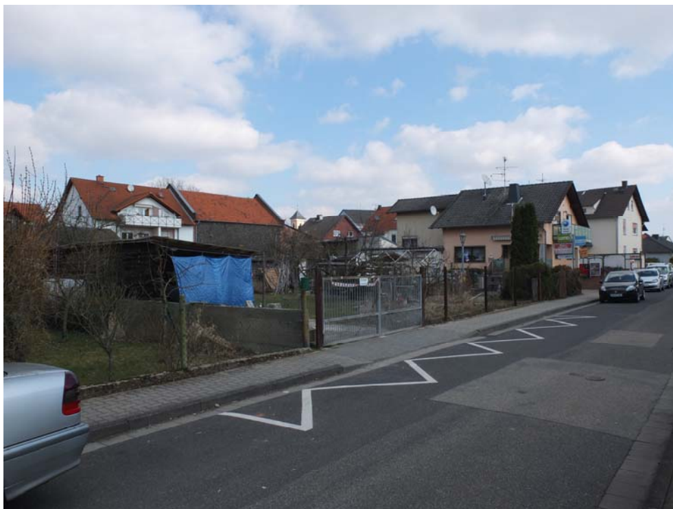
Wassergartenstraße – Blick auf das Plangebiet von Südwesten
