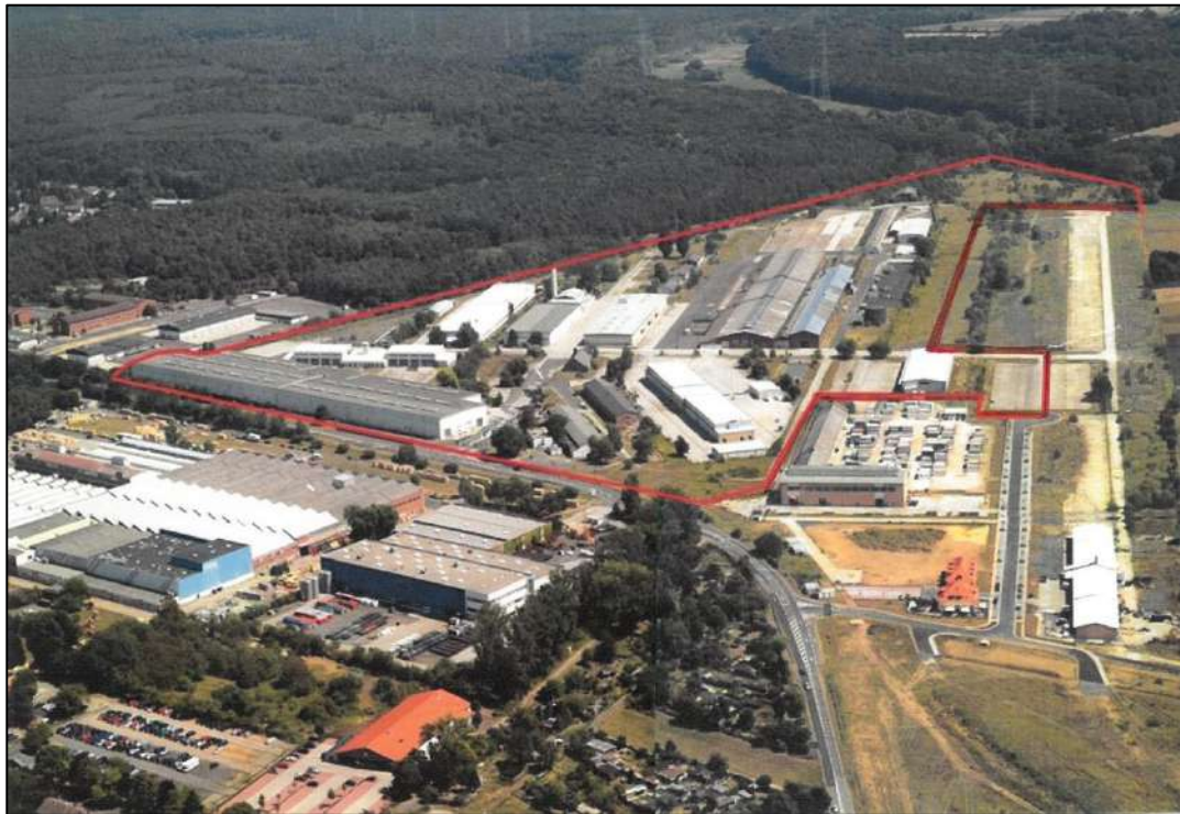
Abb. 11: Schrägluftbild Quelle: Bundesanstalt für Immobilienangelegenheiten
