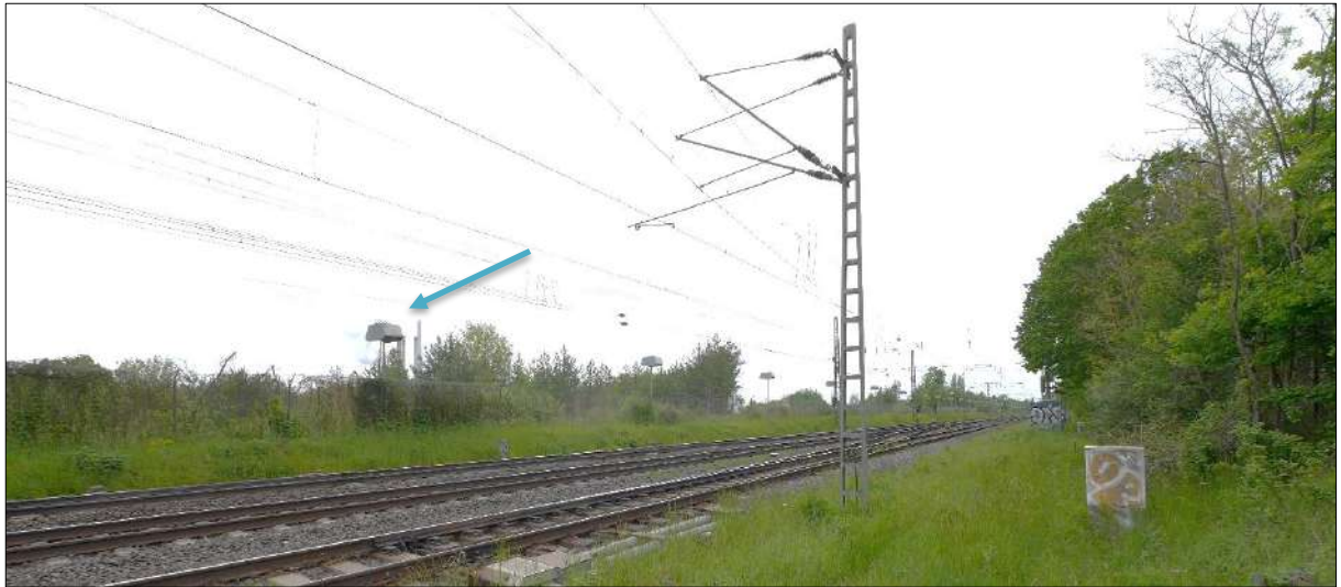
Abb. 31: Blick vom LSG Stadt Hanau über die Gleisanlagen hinweg auf den Vorhabenbereich Erkennbar sind die Schornsteine des Kraftwerks Staudinger (blauer Pfeil).
