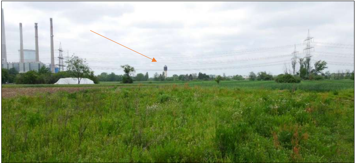
Abb. 35: Blick auf das Kraftwerk Staudinger und die Freileitungen
