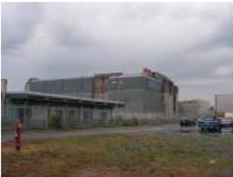
Abbildung 11,12: Fotos unterschiedlicher Baustrukturen
