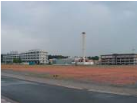
Abbildung 13,14: Fotos zentrale Potenzialfläche von knapp 3ha, Gebäude der ehemaligen Alkem GmbH
